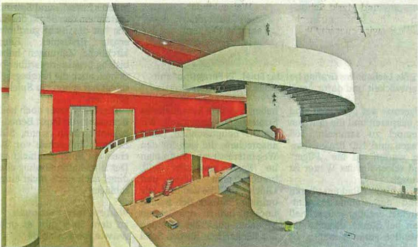
Blick vom ersten Stock auf die geschwungene Treppe und die Aula (mit Fußbodenheizung). Höhe des lichtdurchfluteten Raumes: rund 9,50 Meter.
